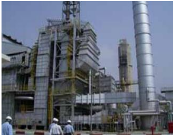
アンモニア肥料製造工場
